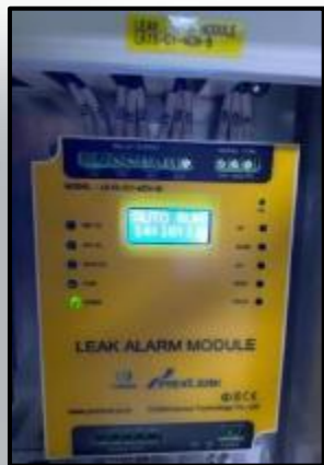
現場モニタリング
